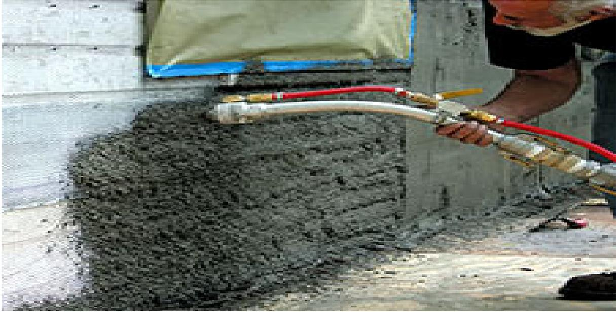
\*تستخدم الخرسانة المقذوفة في العديد من الأعمال الإنشائية الخرسانية ويمكن أن تستخدم بصفة خرسانة عادية ويمكن أن تكون خرسانة مسلحة وعلى الأغلب تستخدم الخرسانة المقذوفة خرسانة مسلحة وسنورد فيما يلي بعض الاستخدامات على سبيل المثال
